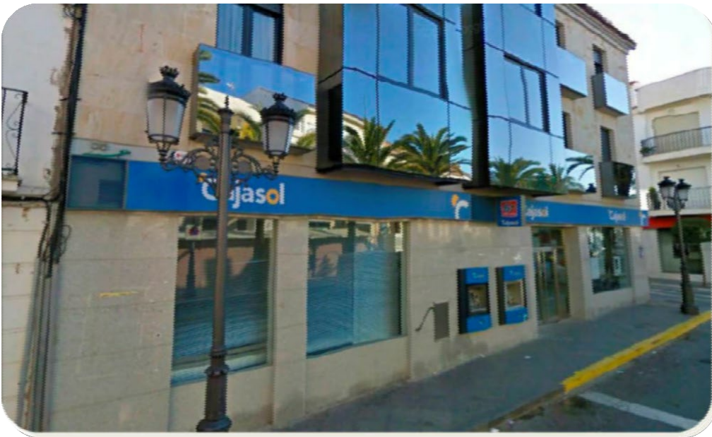
REMODELACIÓN OFICINA BANCARIA Lepe (Huelva)
