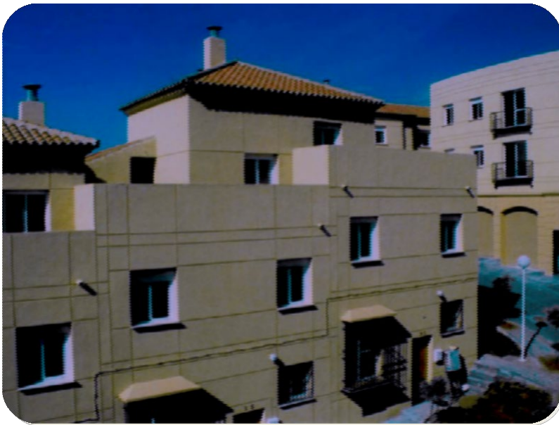
CONSTRUCCION 23 VIVIENDAS Alcalá de Guadaira (Sevilla)
