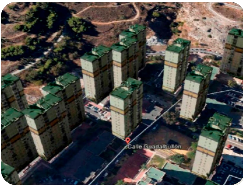
RECALCE Y REPARACIÓN DAÑOS BLOQUE EN C/ GUADABULLÓN, 11 BDA HUERTA DE LA PALMA
